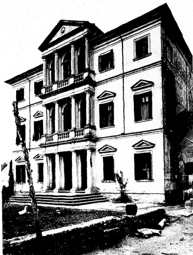
La Villa Trieste a Tavello di Limena (facciata principale)
