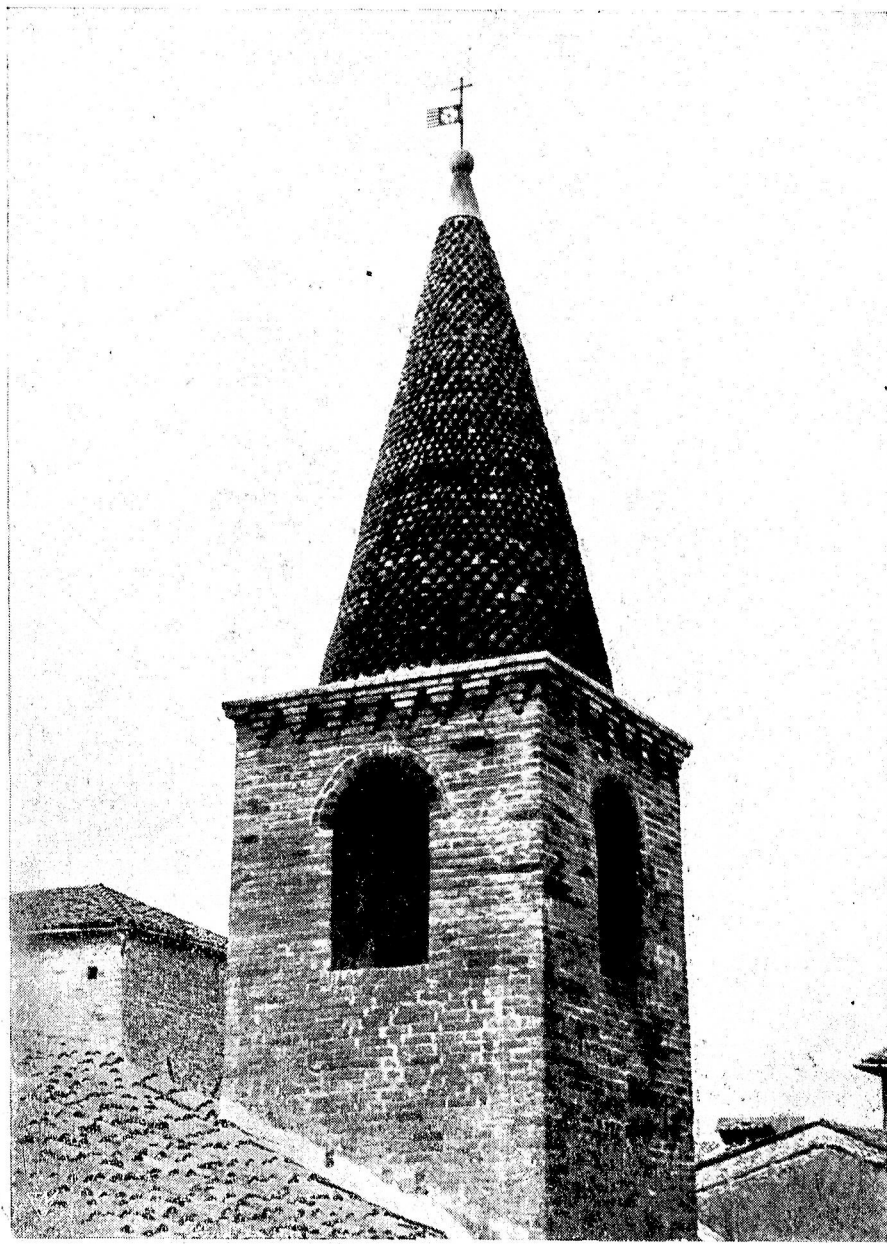
CCLXVII - CAMPANILETTO DELLA CHIESA DI S. AGNESE DOPO IL RESTAURO
