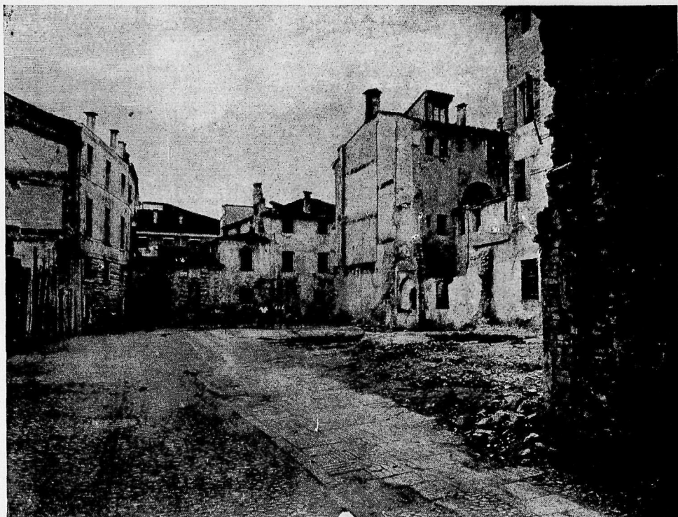
XII - IL QUARTIERE DI S. LUCIA DOPO LE PRIME DEMOLIZIONI
