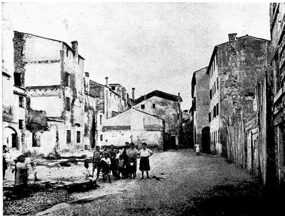
XI - IL QUARTIERE DI S. LUCIA ALL'INIZIO DELLE DEMOLIZIONI VIA BOCCALERIE
