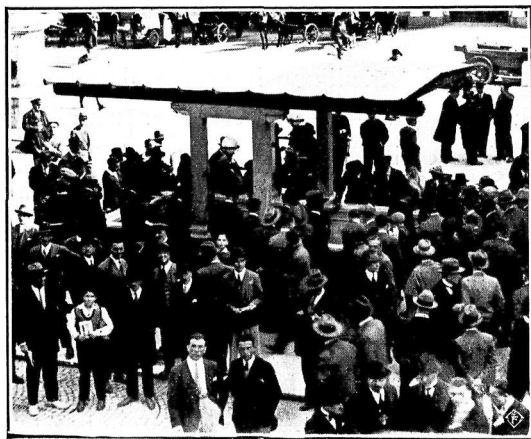
CXXXIX - ALBERGO DIURNO COBIANCHI LA SCALA D'ACCESSO NEL GIORNO DELLA INAUGURAZIONE 11 OTTOBRE 1927 - V
