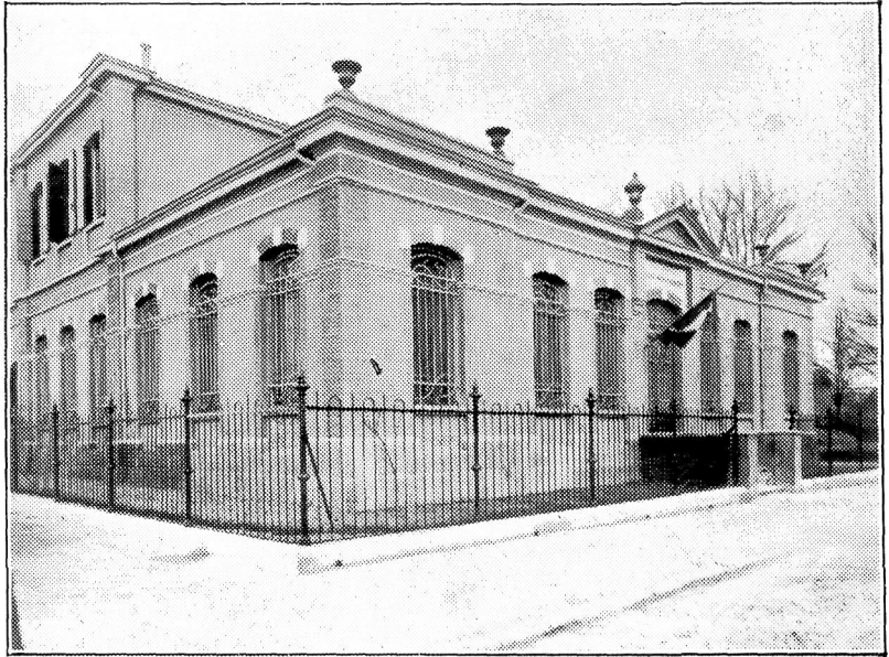
CLV - ASILO INFANTILE DI SALBORO "EGLE WOLLEMBORG" LATO VERSO L'INGRESSO
