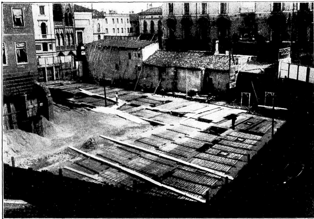
CXXXVI - I LAVORI PER IL NUOVO CORPO DI FABBRICA DEL PALAZZO CIVICO IL SOFFITTO DEL SOTTERRANEO - PAVIMENTO DEL PIANO TERRA IN CORSO DI LAVORO
