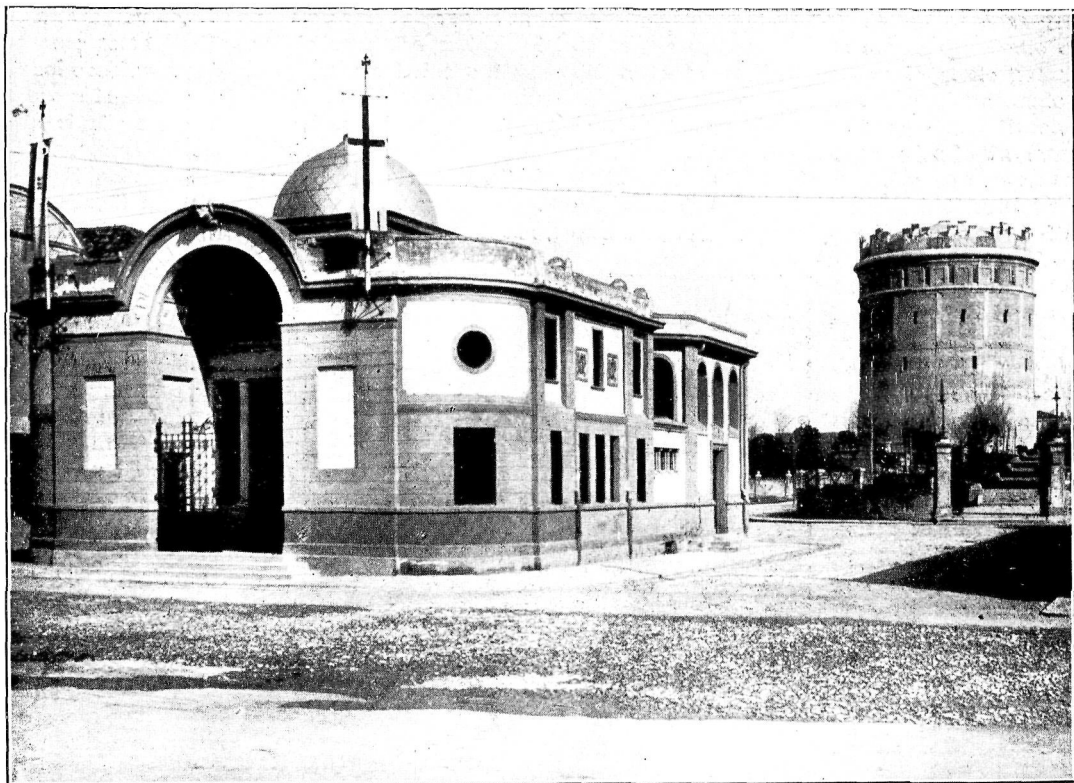
CXXX - LA CASA DEL MUTILATO DI PADOVA ERETTA PER SOTTOSCRIZIONE CITTADINA SU TERRENO DONATO DAL COMUNE
