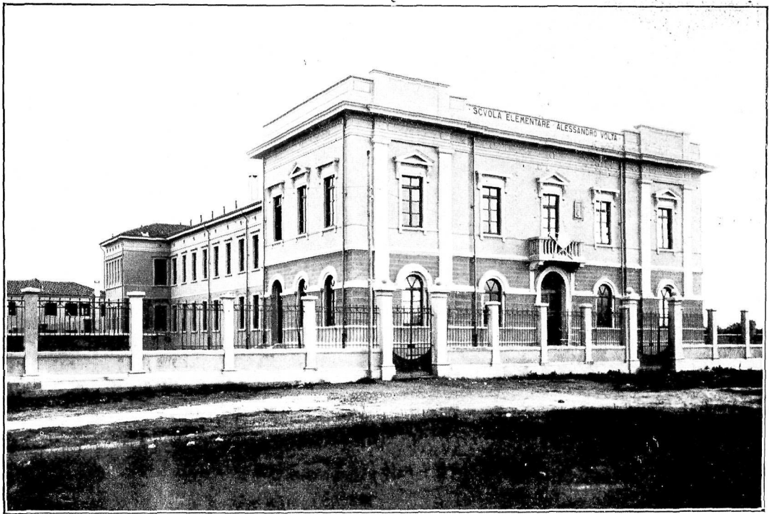
CLT - SCUOLA ELEMENTARE SUBURBANA «ALESSANDRO VOLTA»
