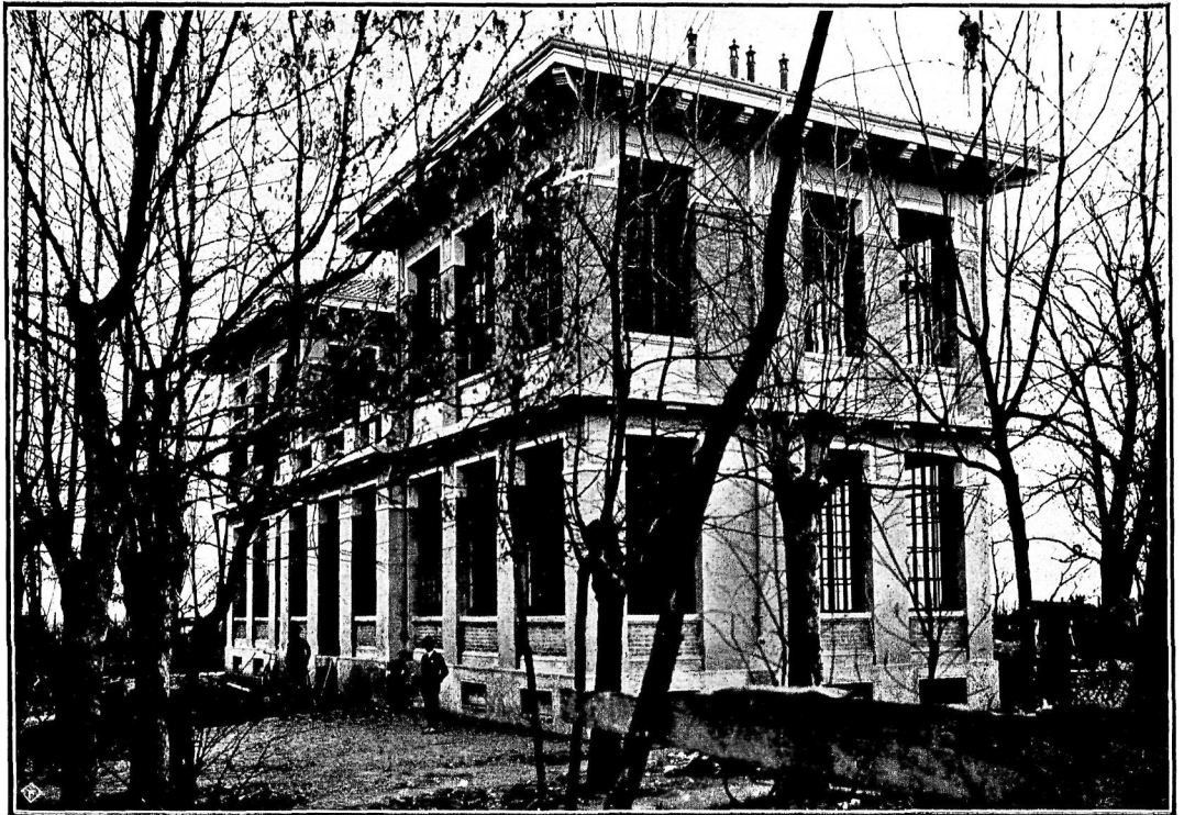
CLII - SCUOLA ELEMENTARE ALL'APERTO «CAMILLO AITA» FRONTE PRINCIPALE
