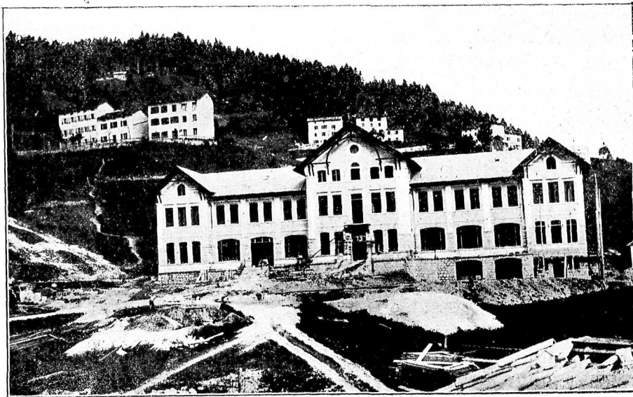
CI - COLONIA ALPINA REGIONALE DI ENEGO L'EDIFICIO PRINCIPALE
