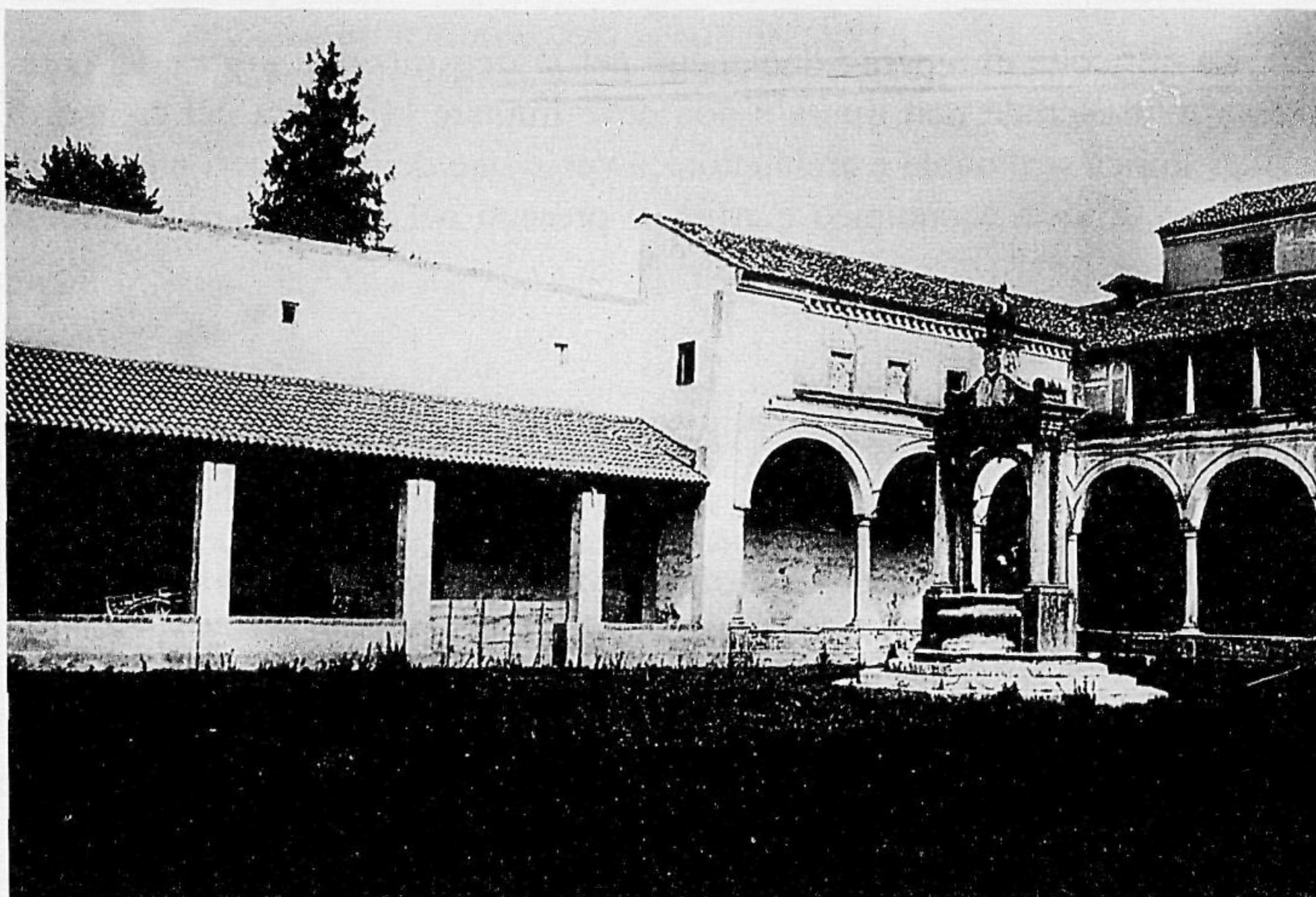
Fig. 9. A.M.N.A., Carceri-chiostro cinquecentesco dopo il crollo con sua successiva parziale ricostruzione (attualmente demolita) , foto b/n su concessione del Ministero dei Beni Culturali e Ambientali.
