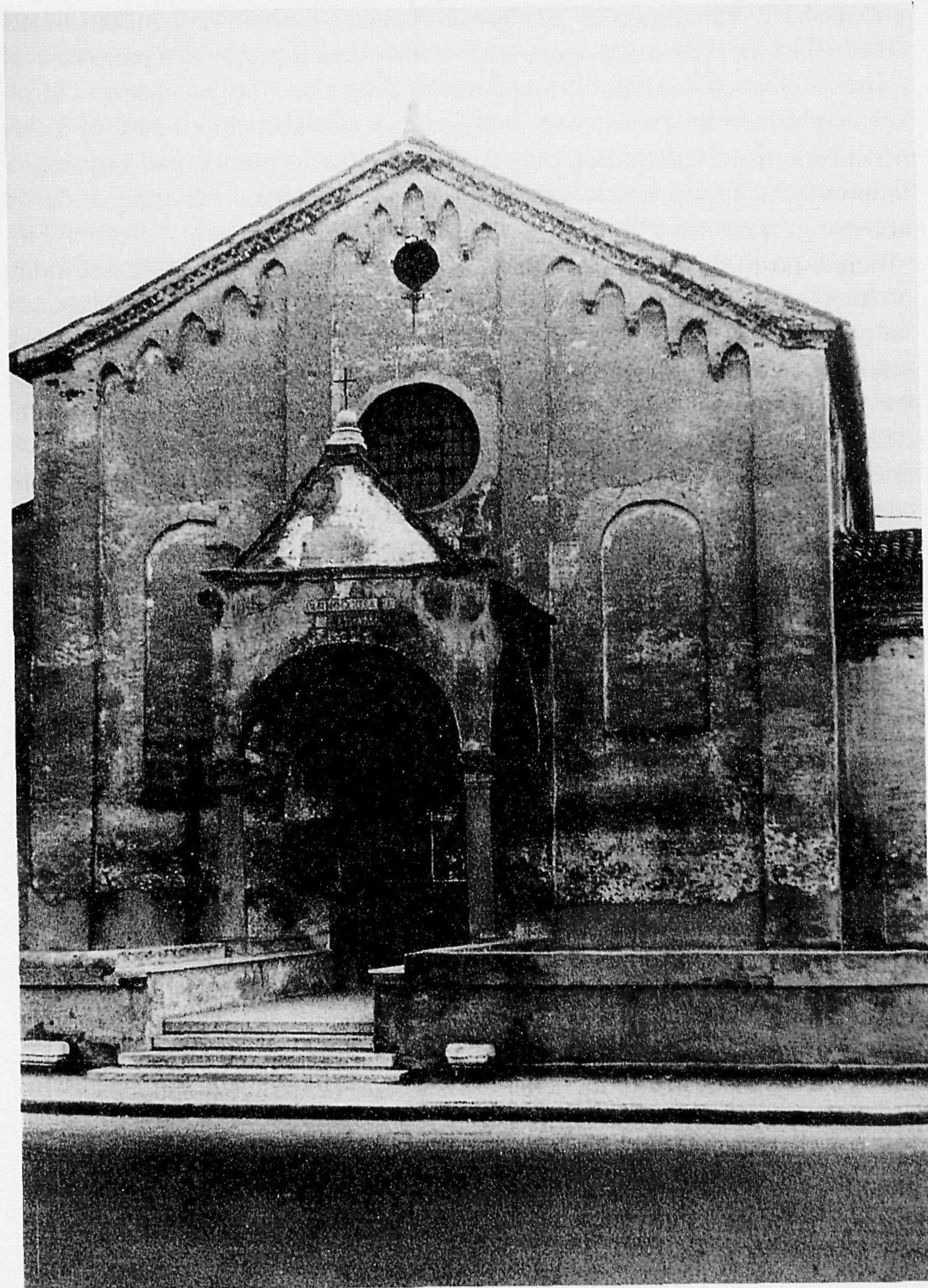
Fig. 11. Facciata della chiesa dopo il restauro del 1961.
