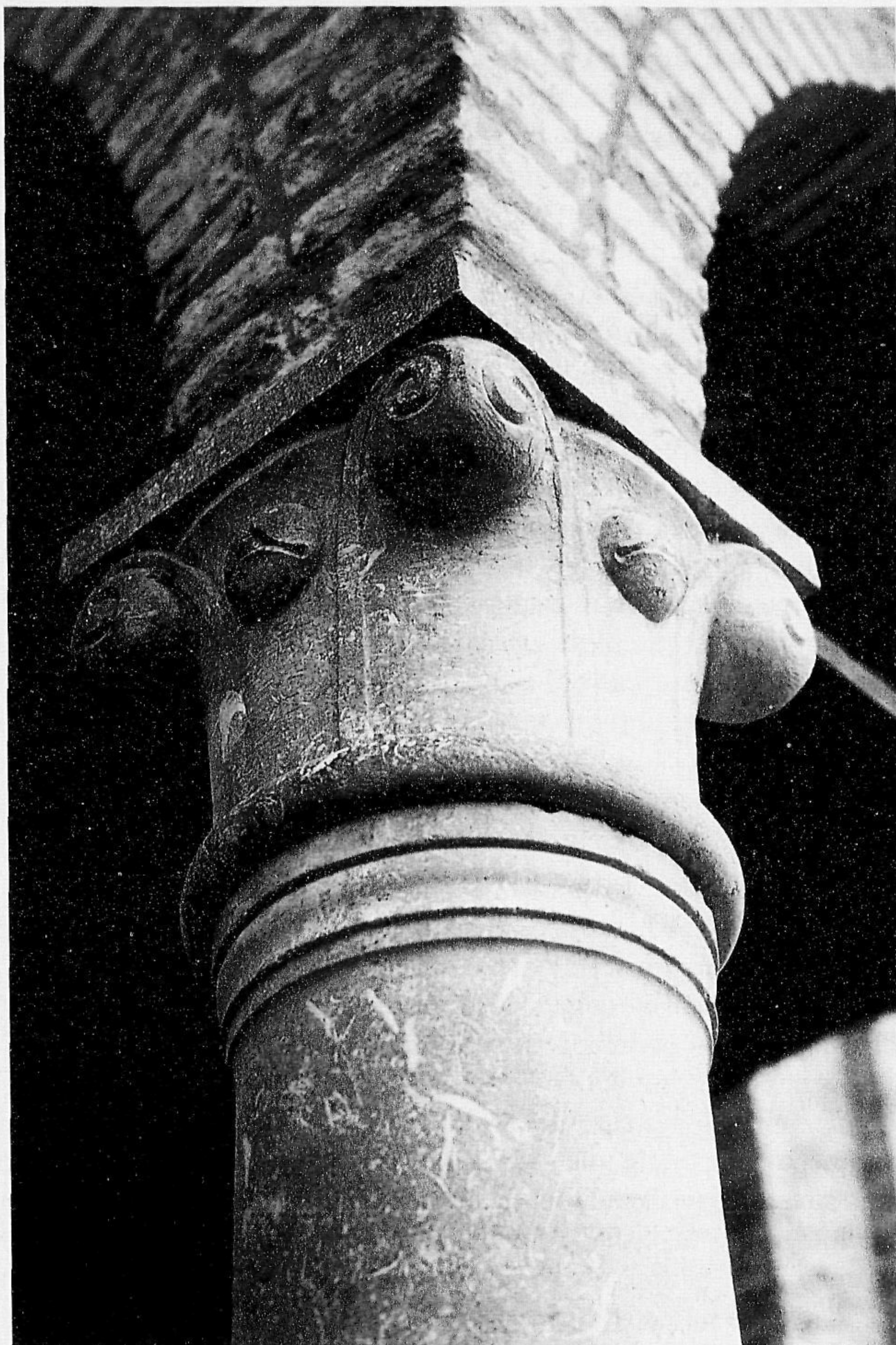
Fig. 12. Capitello restaurato. Particolare.
