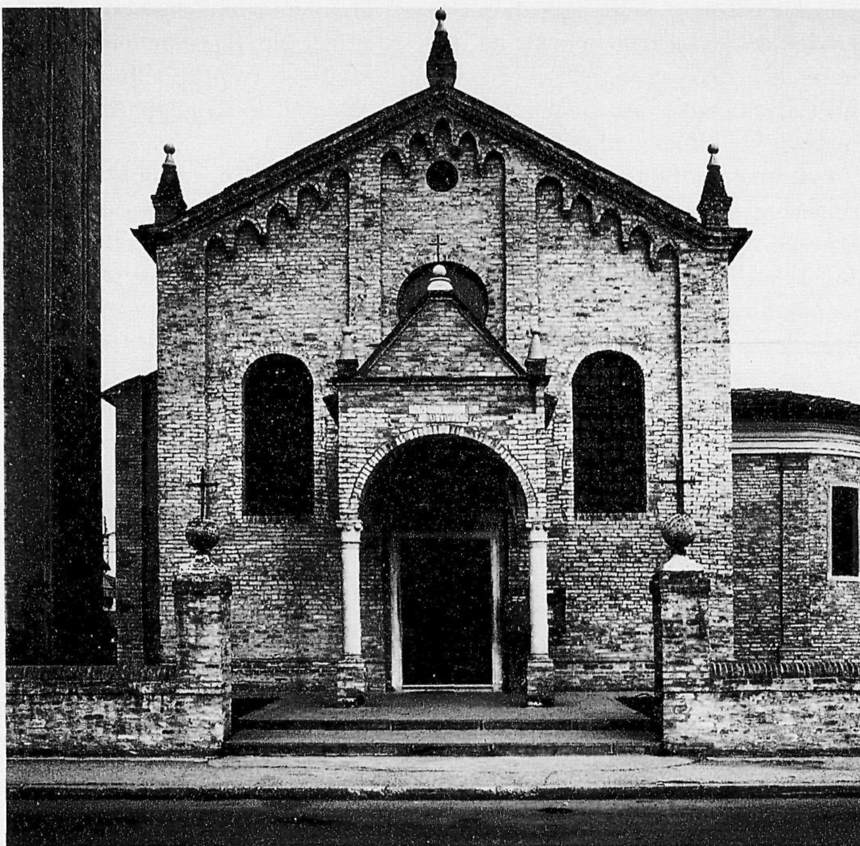
Fig. 1. Facciata della chiesa di S. Martino nel suo stato attuale, dopo il restauro del 1978.
