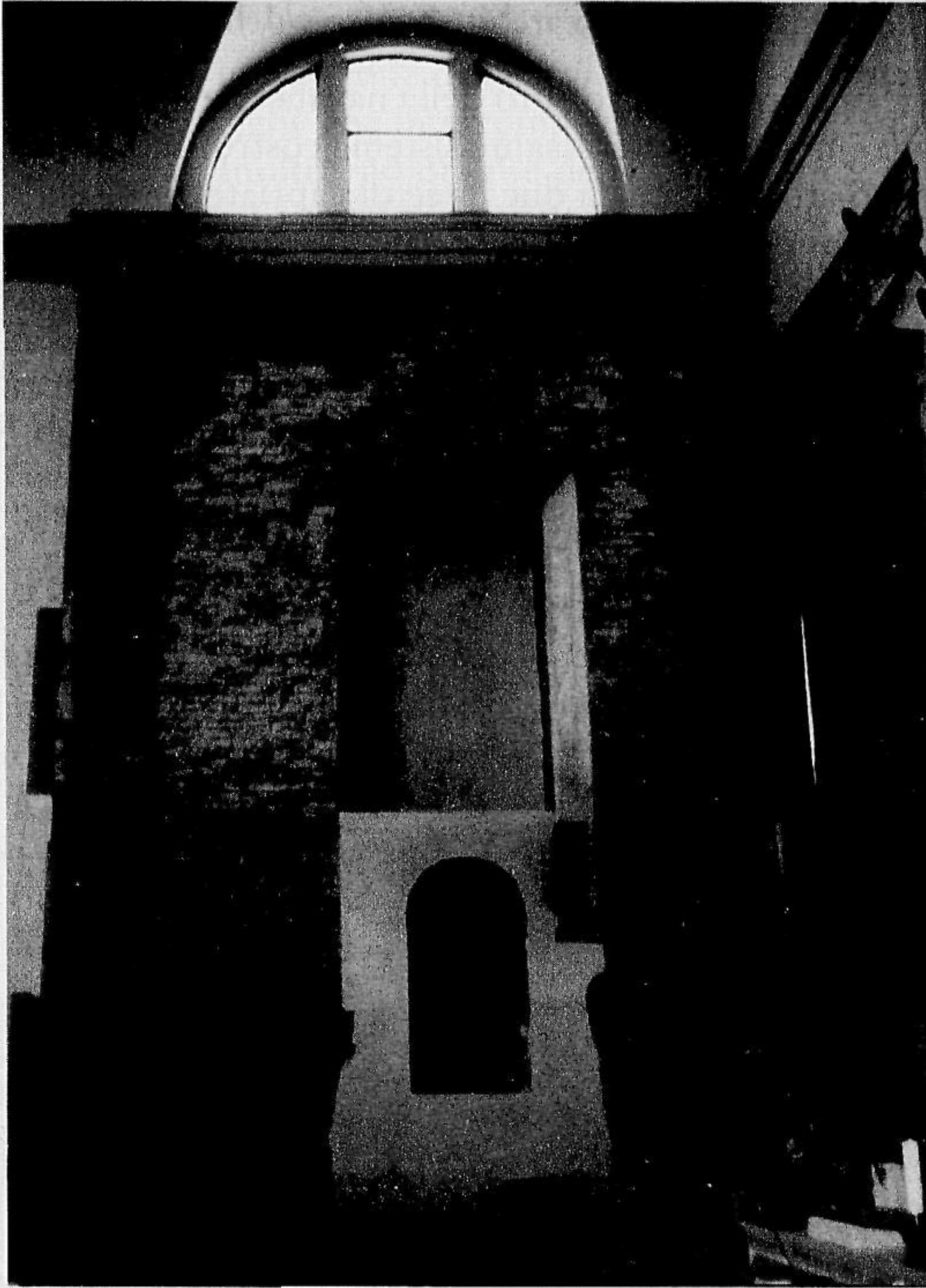
Fig. 1 - Parete nord - antico transetto sinistro.
