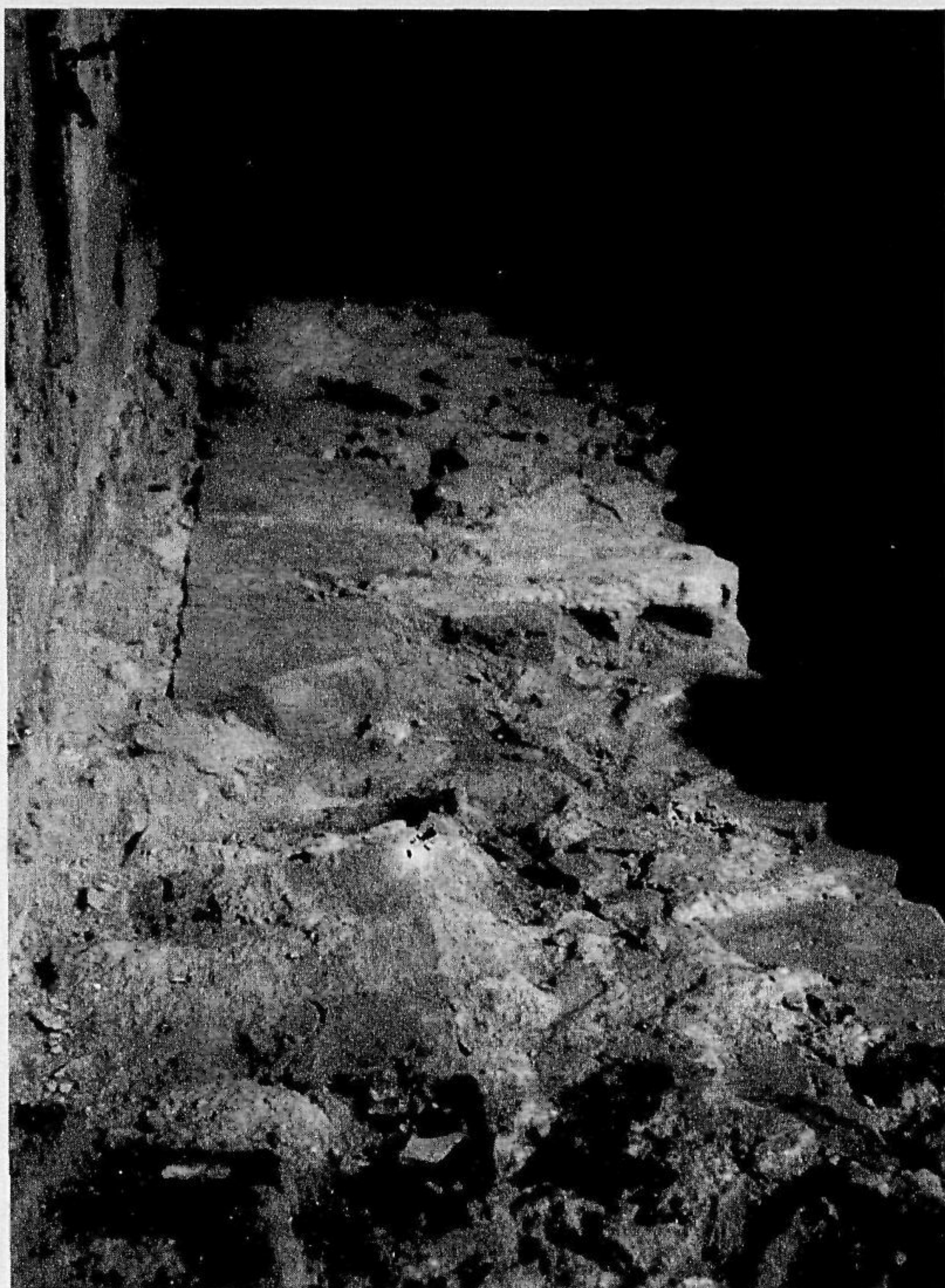
Fig. 9a - Particolare del muro esterno dell'antica abside semicircolare(lato sinistro).
