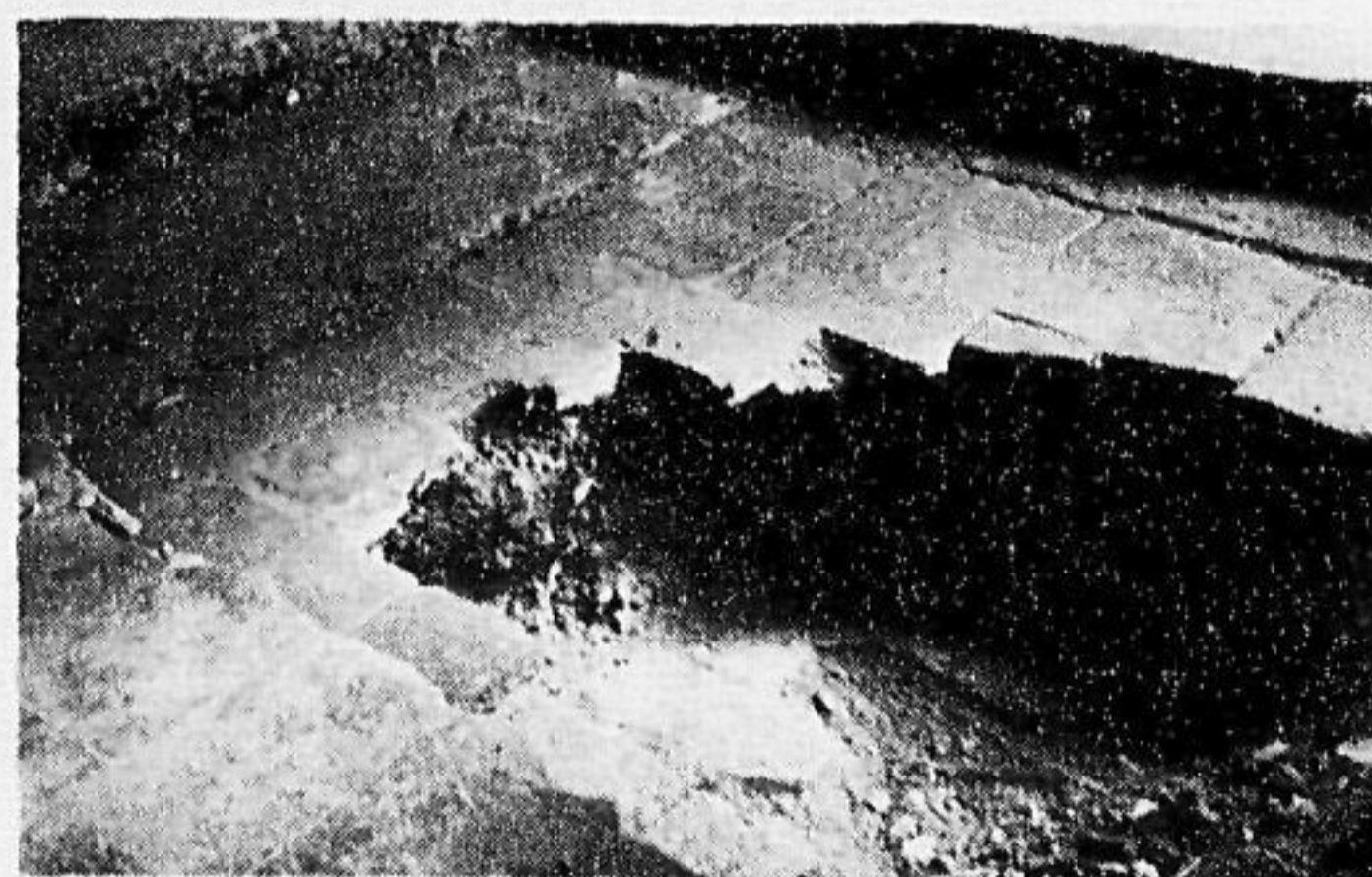
FIG. 9 - Sacrestia. 14 centimetri sotto al pavimento moderno, quello del 1764; più sotto di cm 41 è ancora il primo pavimento.
