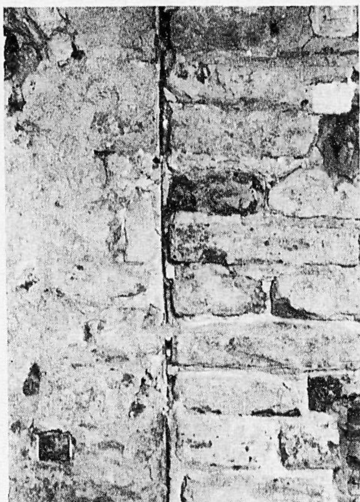
FIG. 4 - Muro divisorio tra la sacrestia ed il presbiterio: attacco tra due muri di epoca diversa, applicato a quello di destra, nell'interstizio, è ancora visibile l'intonaco. Erano forse parte del primo edificio ecclesiale o delle « casette » che costituirono il primo convento.
