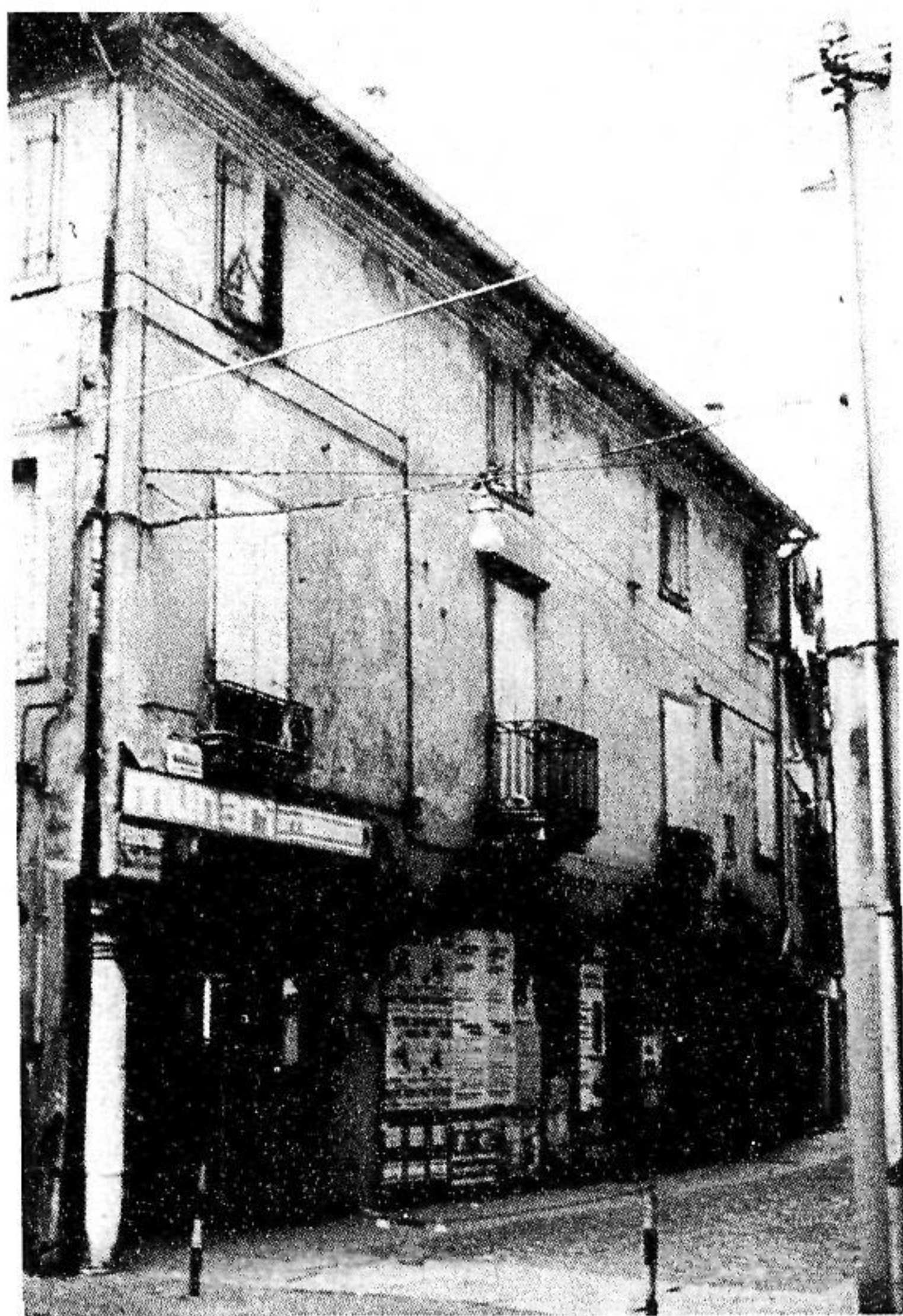
FIG. 3 - PADOVA, Case di via Marsala, civ. n. 1/3.
