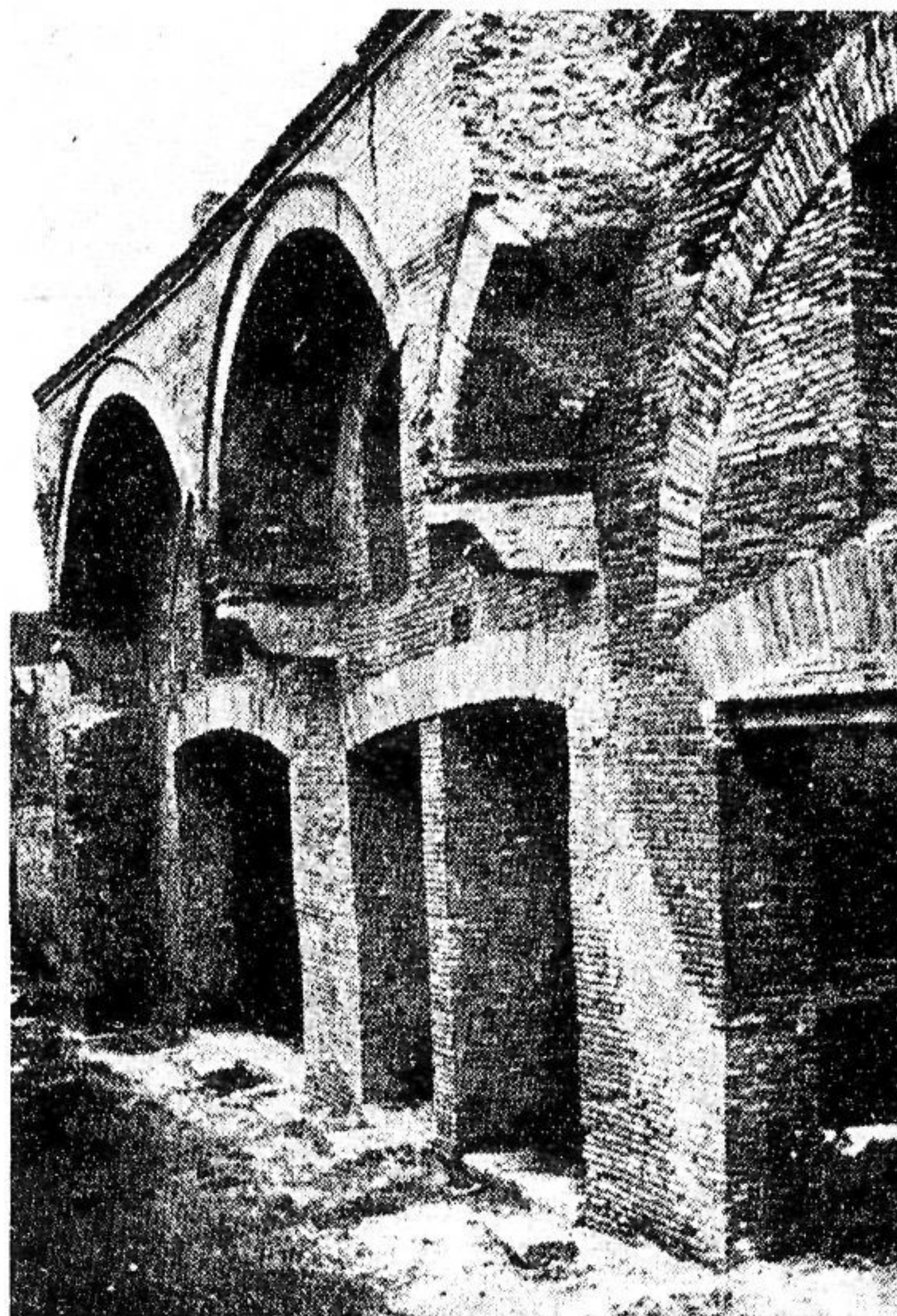
FIG. 2 - OSTIA, Casa romana di via della Fortuna.
