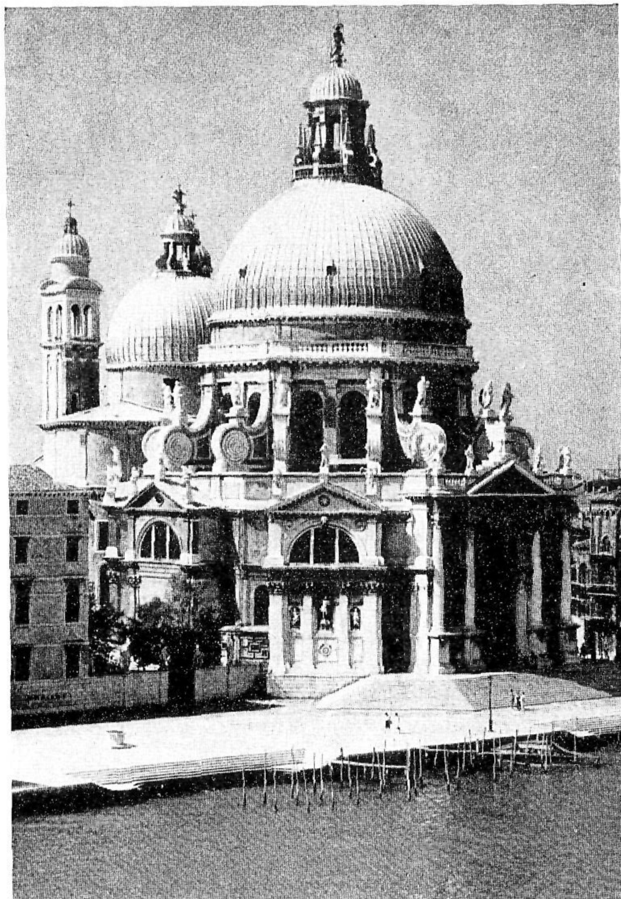
FIG. 35 - Venezia: Chiesa di S. Maria della Salute. Esterno (Arch. Baldassare Longhena).
