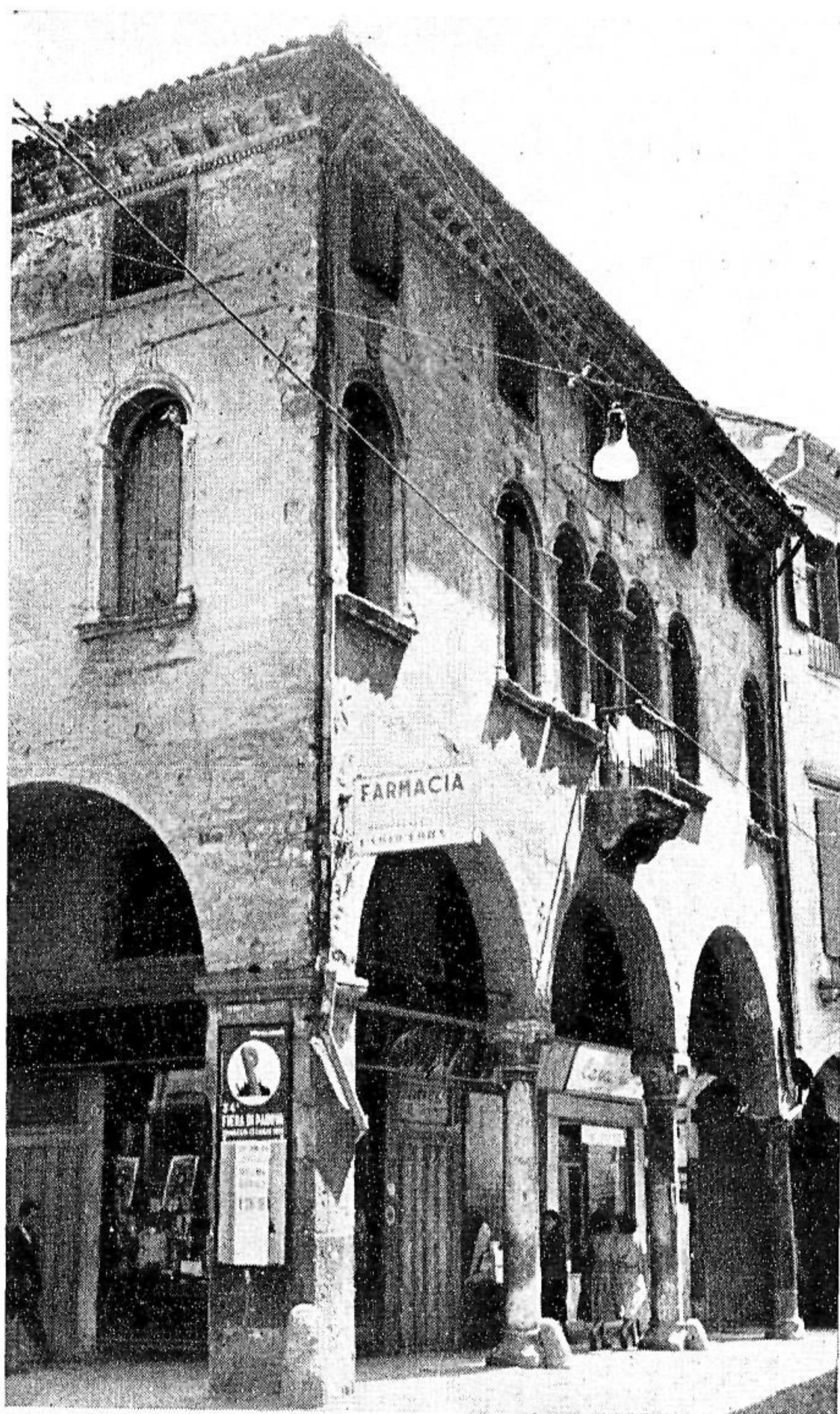
Fig. 4 - CASA DELLO SPEZIALE AL «POMO D'ORO» sull'angolo di piazza Duomo e di via D. Manin.
