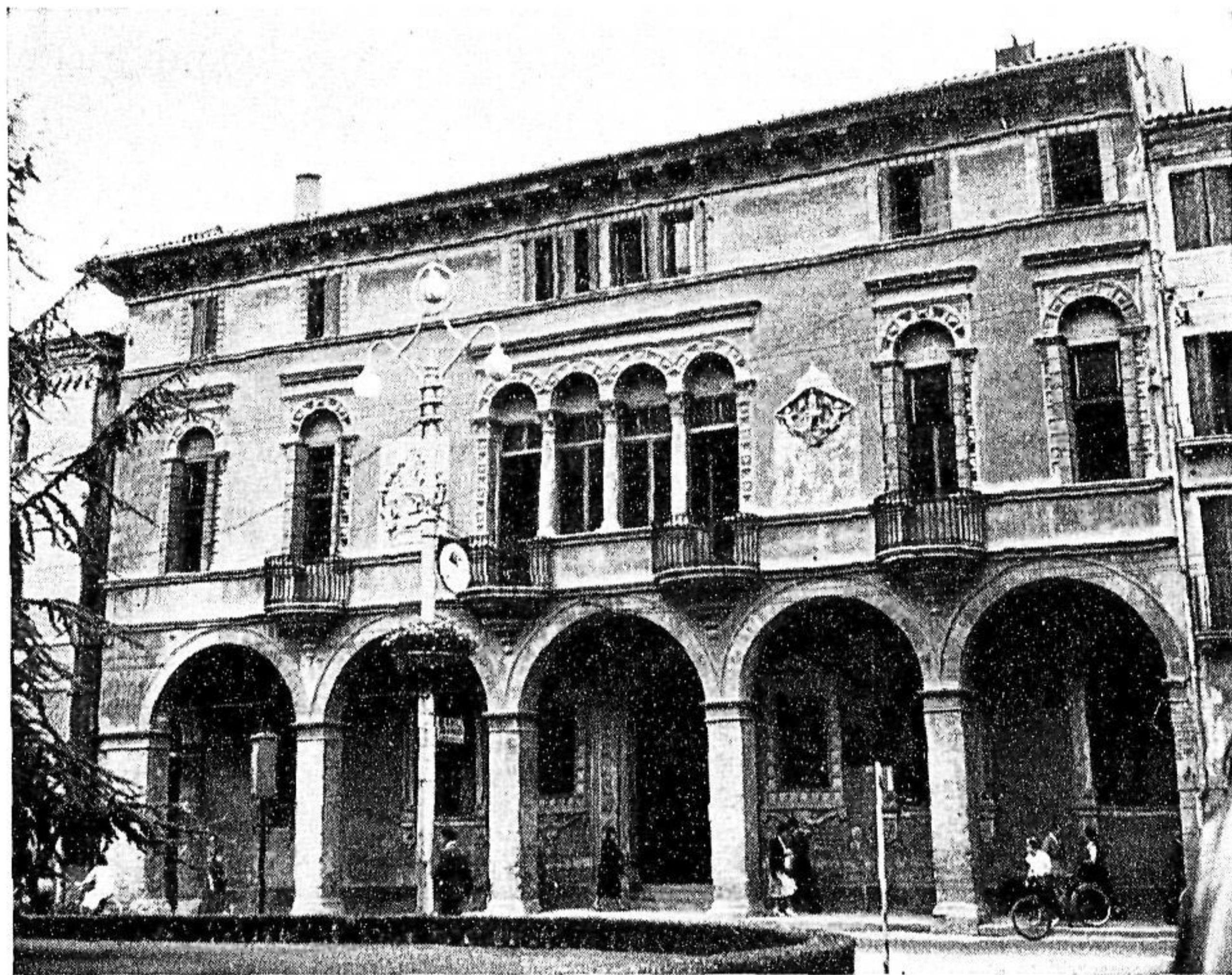
Fig. 3 - PALAZZINA SALA, in via S. Francesco, n. 11.
